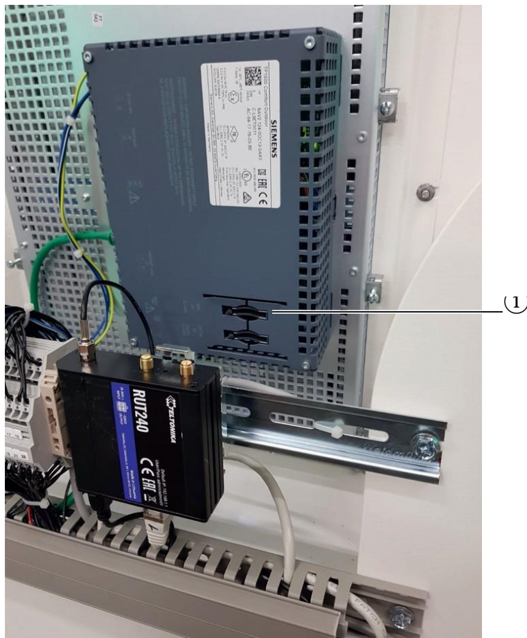
Bild 2-31 ① Position des Einschubschachtes der Kunden-SD-Karte
